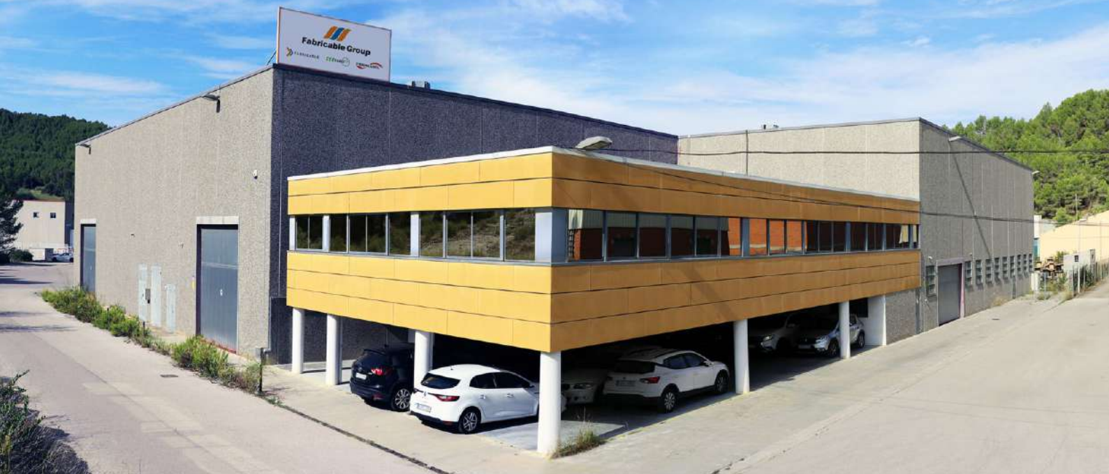
Photographies : Usine CEUCABLE à Sant Vicenç de Castellet
